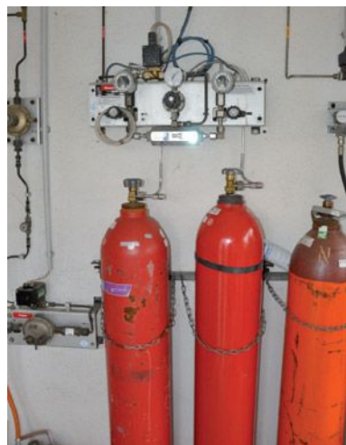
Abbildung 15: Druckgasflaschen mit (Acetylen, rechts) und ohne (Wasserstoff, links) Kennzeichnung „N“
