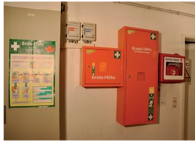
Abbildung 3: Erste-Hilfe-Ausrüstung an zentraler Stelle
