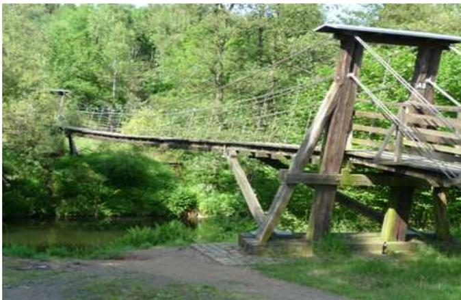
Dieses Bauwerk befindet sich im Ortsteil E. – Ehreshoven und spannt sich über die Agger. Sie wurde ursprünglich gebaut für den Erztransport von Kastor nach Ehreshoven über die Agger. Sie blieb auch nach der Schliessung des Erzabbaus in dieser Gegend in Betrieb und wird heute als Fussgängerbrücke benutzt
